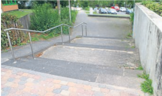
Der Fußweg zwischen der Birkenallee und dem Stadtteilplatz wird barrierearm umgebaut.
